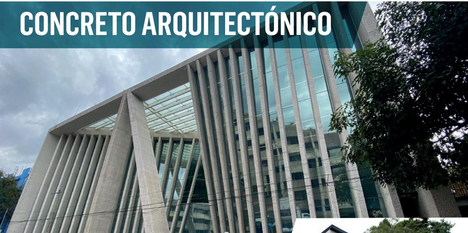
**El Concreto Arquitectónico** de **Concretos Fortaleza**, es un producto especialmente diseñado para satisfacer las demandas estructurales y arquitectónicas del mercado, mediante el color que se obtiene con la adición de pigmentos y/o cemento blanco en combinación con los agregados que estructural y estéticamente satisfagan los requisitos de la obra.
