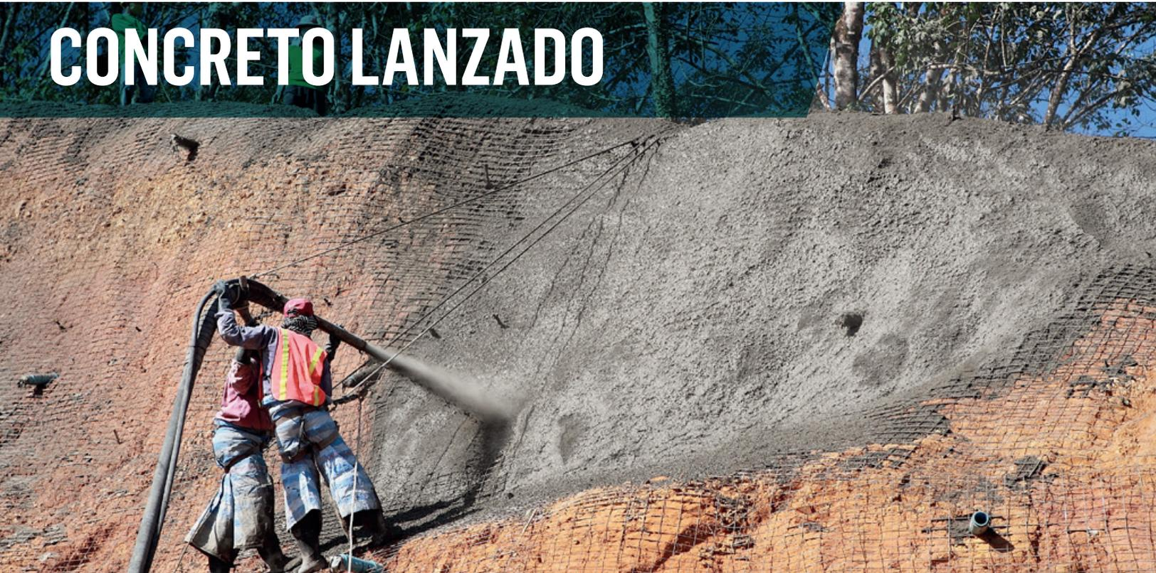
El **Concreto Lanzado de Concretos Fortaleza**, es un producto especialmente diseñado de acuerdo a las recomendaciones estipuladas en el documento elaborado por el ACI Committee 506 "Guide to Shotcrete" para ser proyectado neumáticamente a alta velocidad sobre una superficie con el mínimo de rebote y desperdicio.
