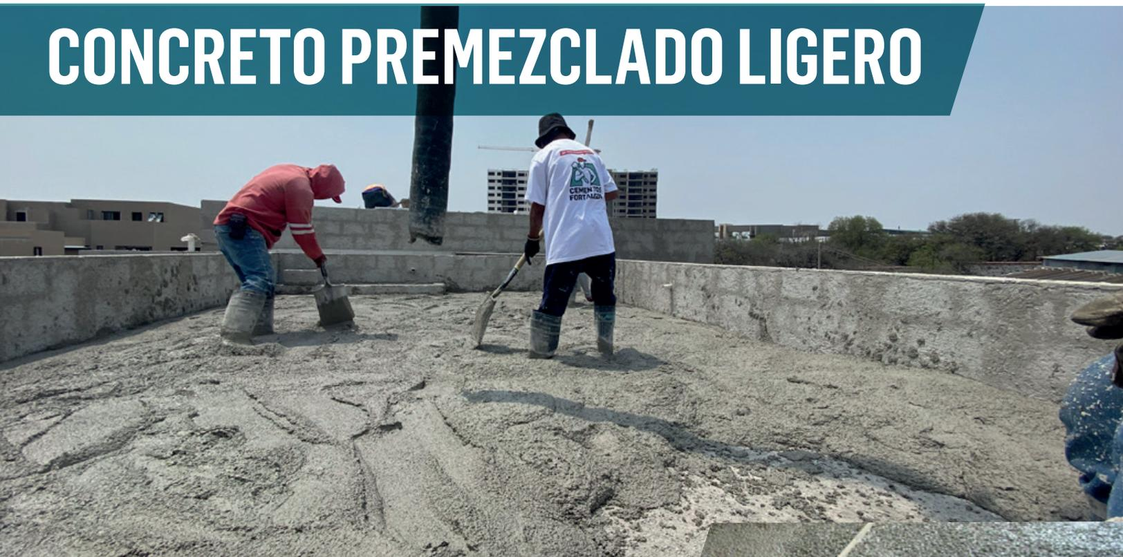
El **Concreto Ligero** de **Concretos Fortaleza**, es un material con peso volumétrico fresco de 1,500 kg/m<sup>3</sup> hasta 1,900 kg/m<sup>3</sup>. Por sus características especiales es un producto diseñado para reducir peso en las estructuras, es aislante térmico y acústico. Permite disminuir las cargas muertas en las estructuras por lo que es posible optimizar el diseño de la cimentación. Se puede clavar, taladrar, atornillar y trabajar con herramientas tradicionales.
