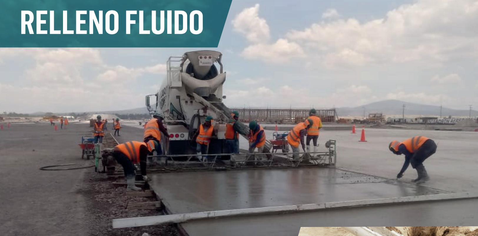
**El Relleno Fluido de Concretos Fortaleza**, es un mortero de peso ligero, que por sus propiedades mecánicas es ideal para rellenar con mayor facilidad huecos que un concreto o mortero convencional no podrían lograr, sustituye los métodos de relleno para bases tratadas.
